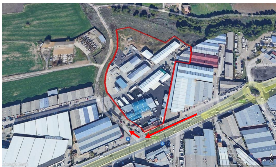
Imagen 2 Acceso a las instalaciones
