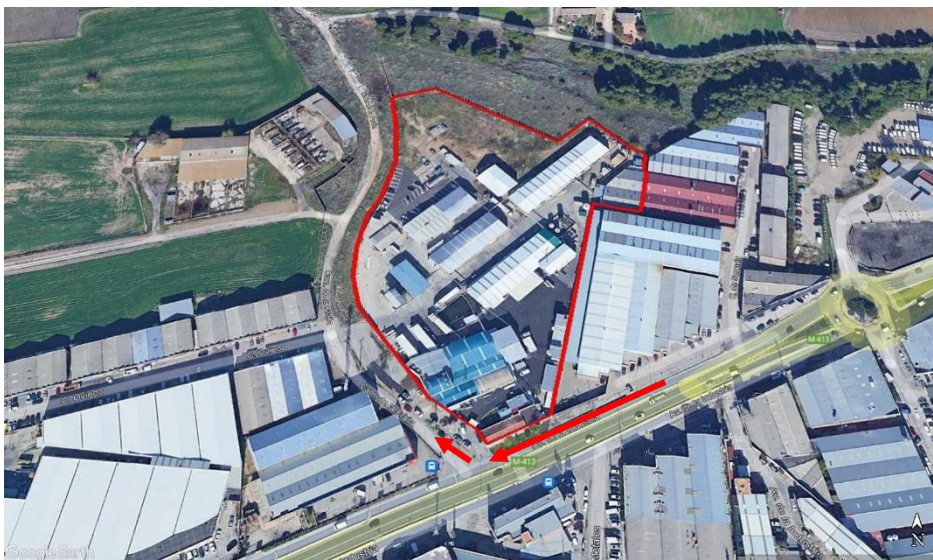
Imagen 2 Acceso a las instalaciones
